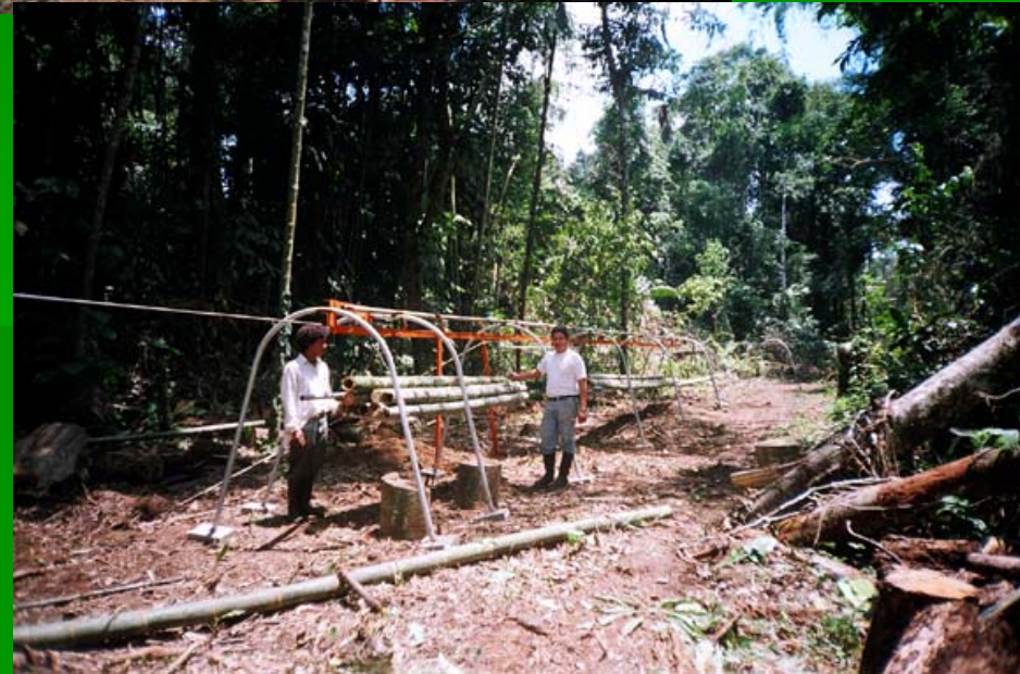
Instalación del sistema de extracción (funicular)
