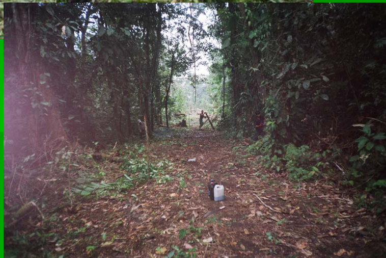
Apertura y adecuación de la trocha
